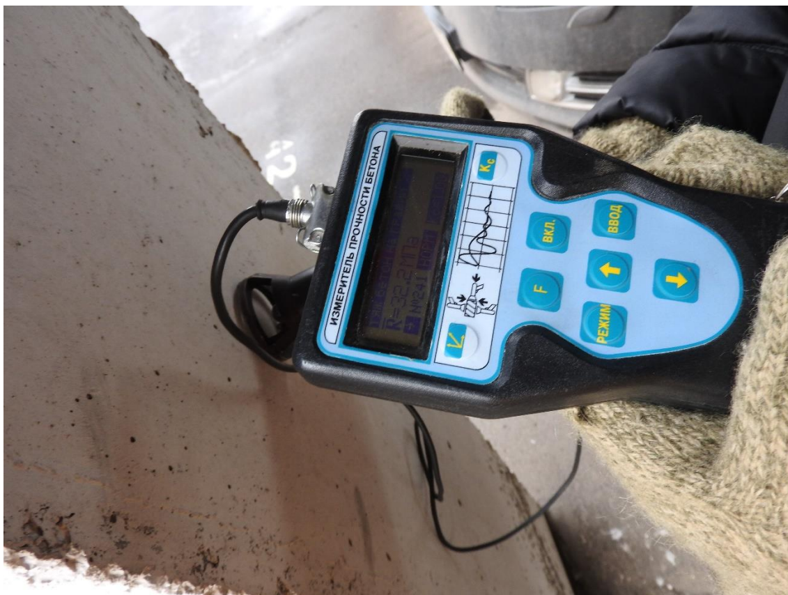
Испытание железобетонных колонн на кровле прибором ИПС-МГ 4.03.
