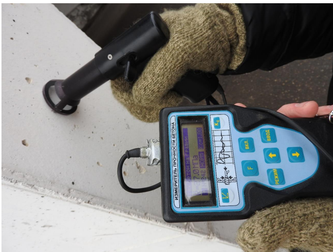
Испытание железобетонных колонн на третьем этаже прибором ИПС-МГ 4.03.
