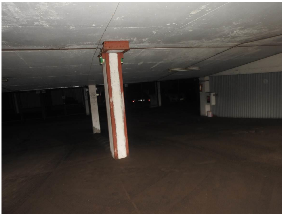
Общий вид колонн.
