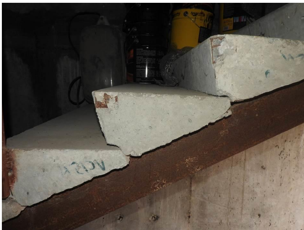
Общий вид ступеней лестниц.
