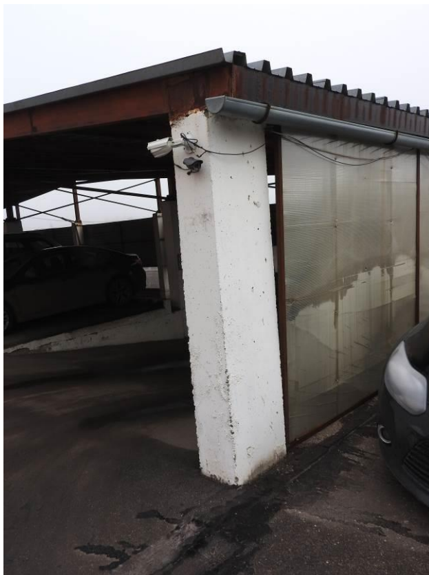
Общий вид колонн.
