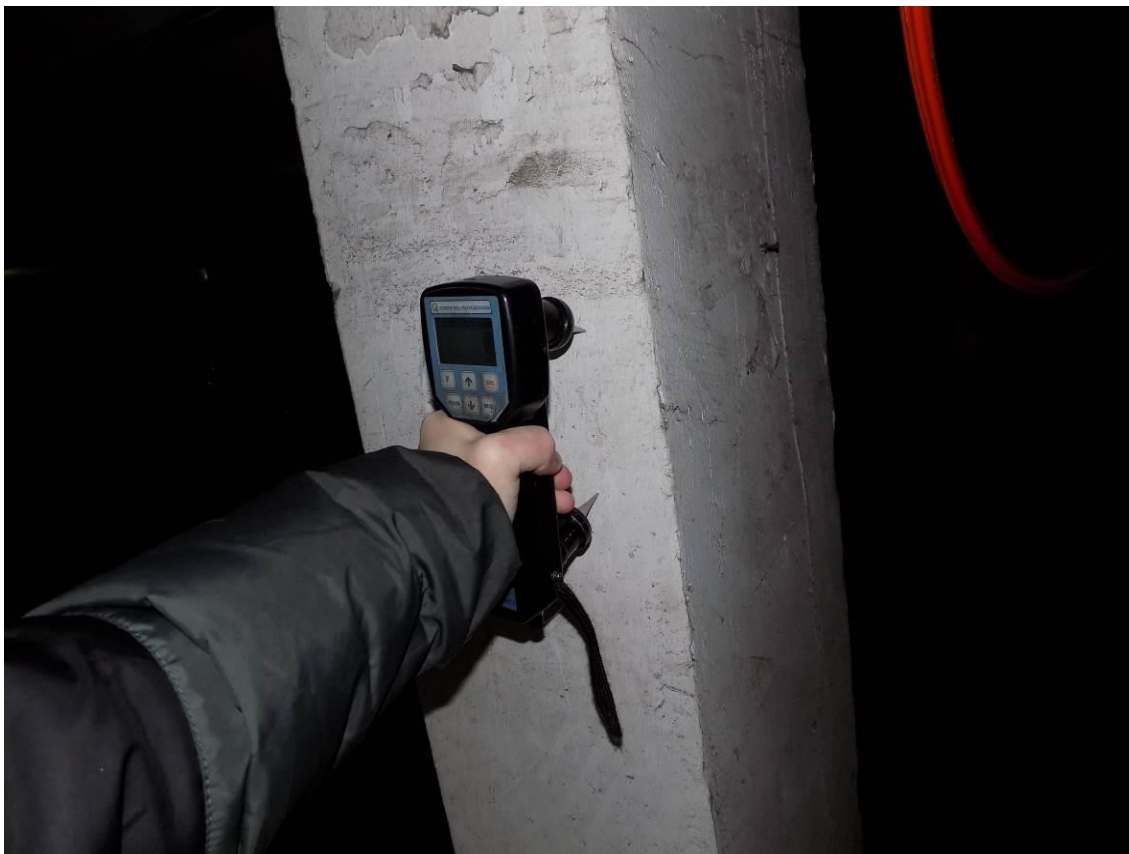
Испытание колонн второго этажа прибором УКС-МГ4.
