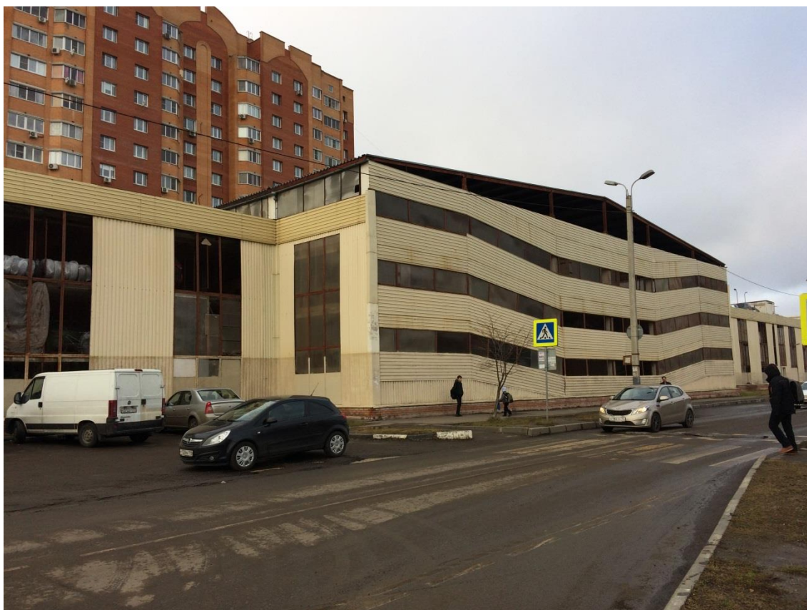
Фасад обследуемого здания вдоль оси «А-А/1».
