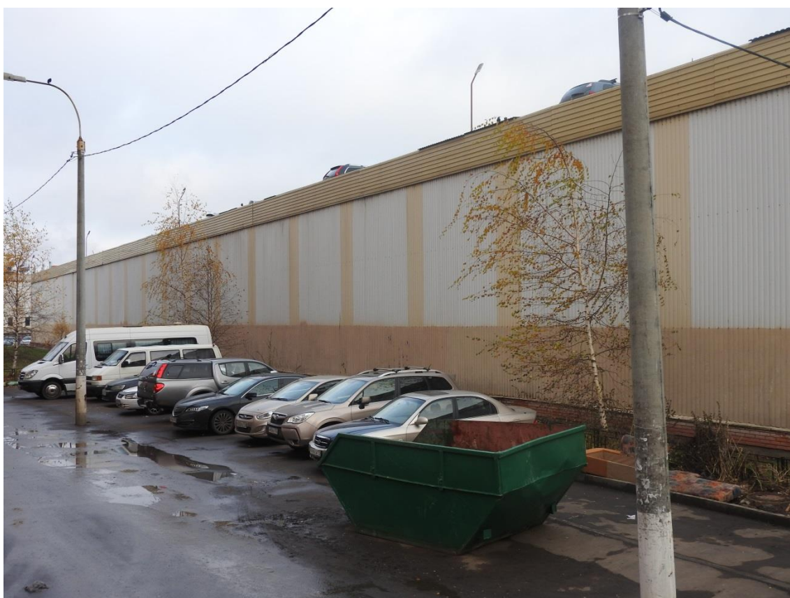
Фасад обследуемого здания по оси «Г».
