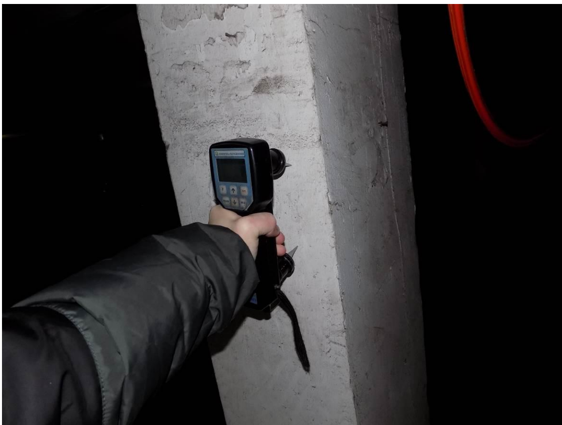
Замеры прочности колонны ультразвуковым методом
