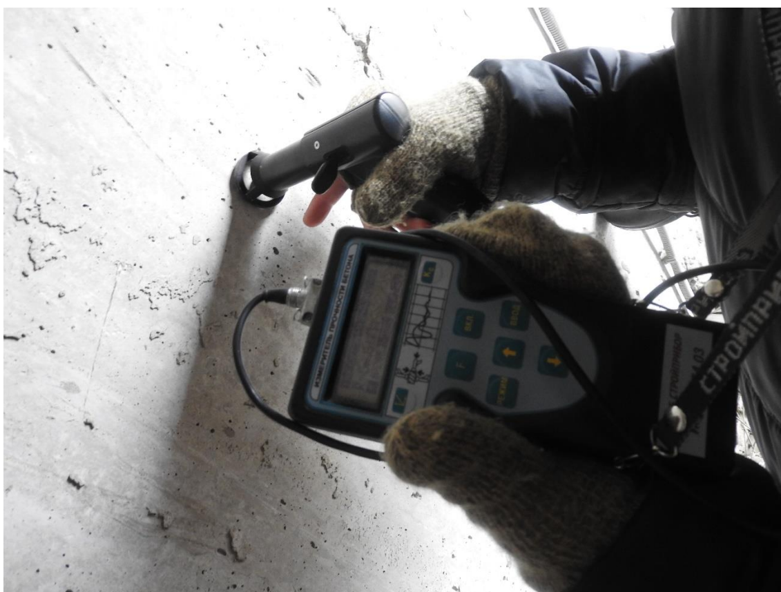
Испытание железобетонных стен лестничных клеток прибором ИПС-МГ 4.03.
