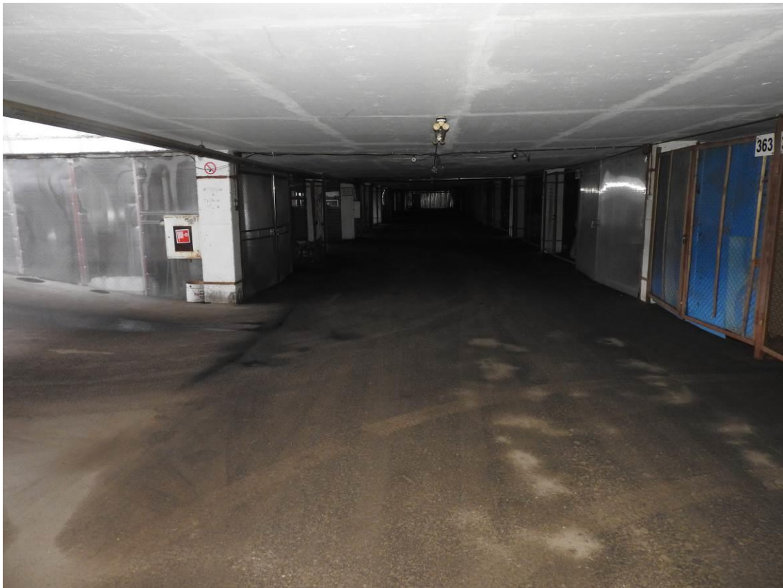
Общий вид внутренних помещений третьего этажа
