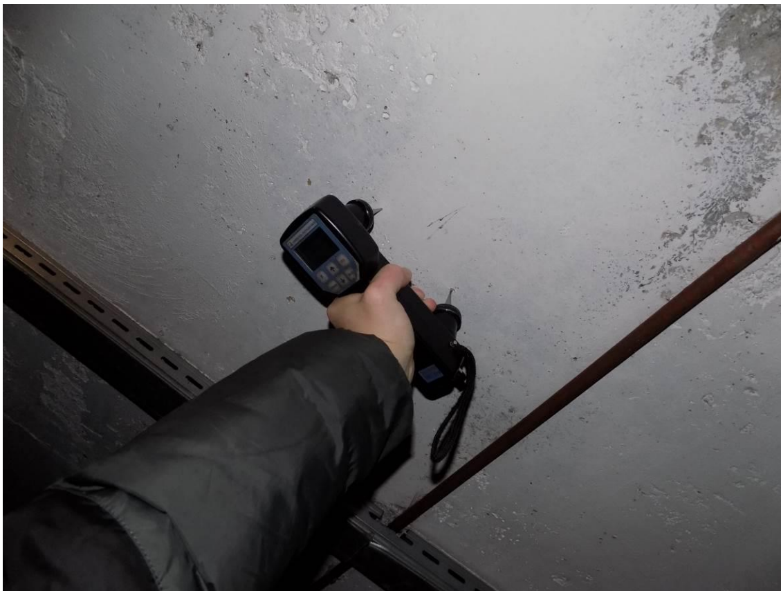
Замеры прочности плиты перекрытия ультразвуковым методом
