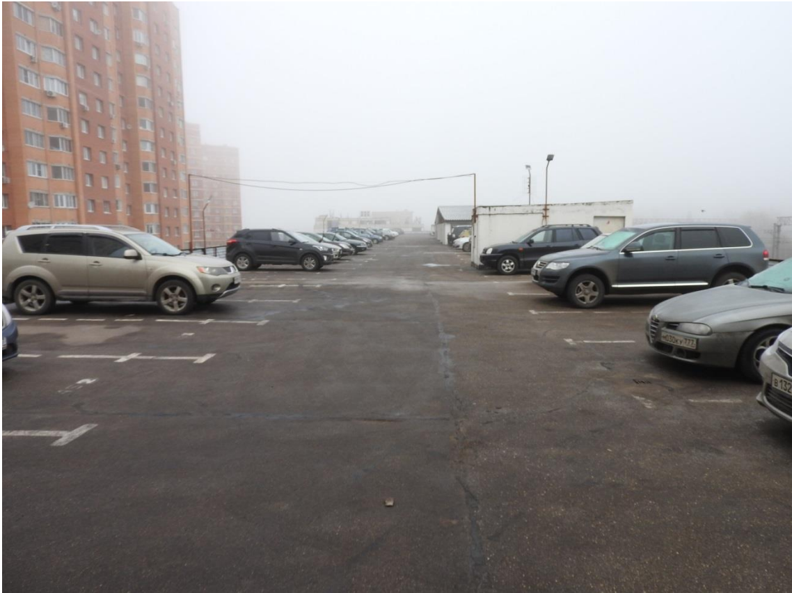
Общий вид эксплуатируемой кровли
