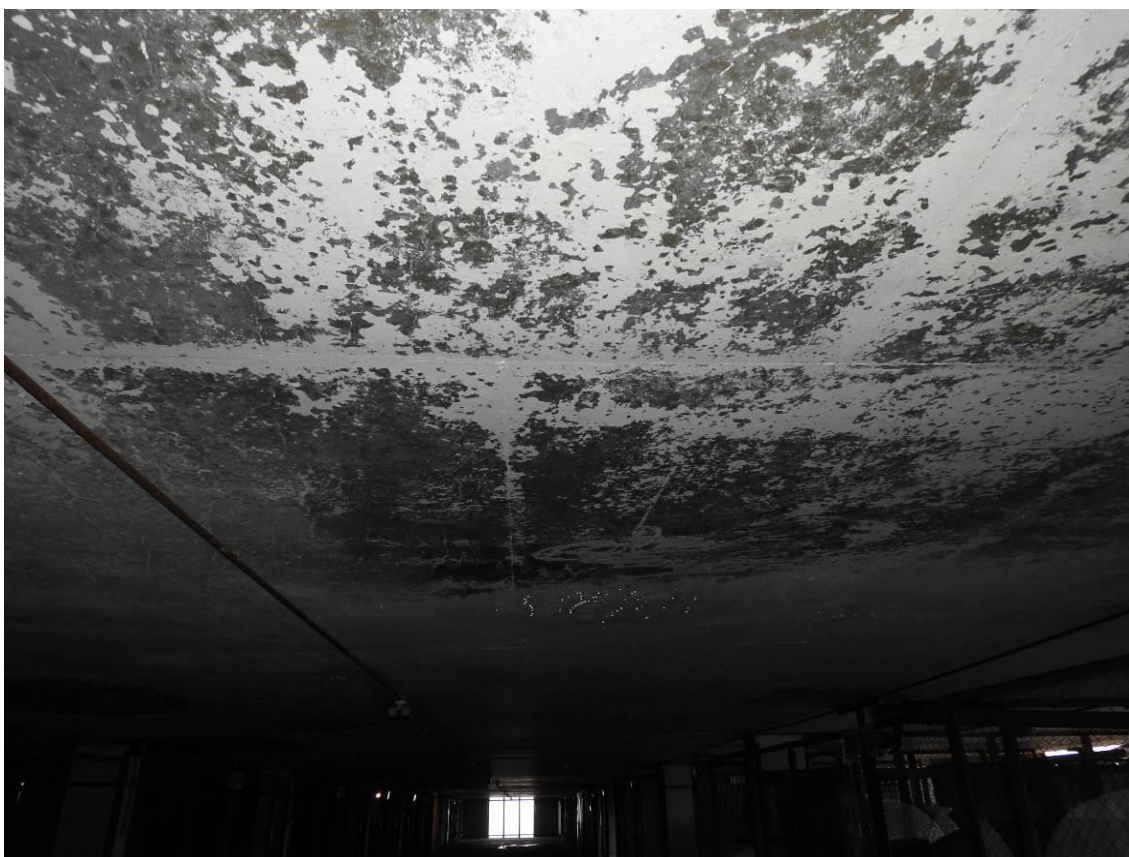
Общий вид перекрытия
