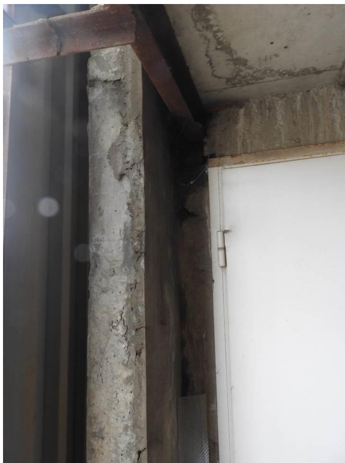
Общий вид монолитной стены входной группы
