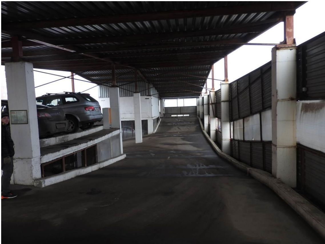
Общий вид рампы - выезд на кровлю
