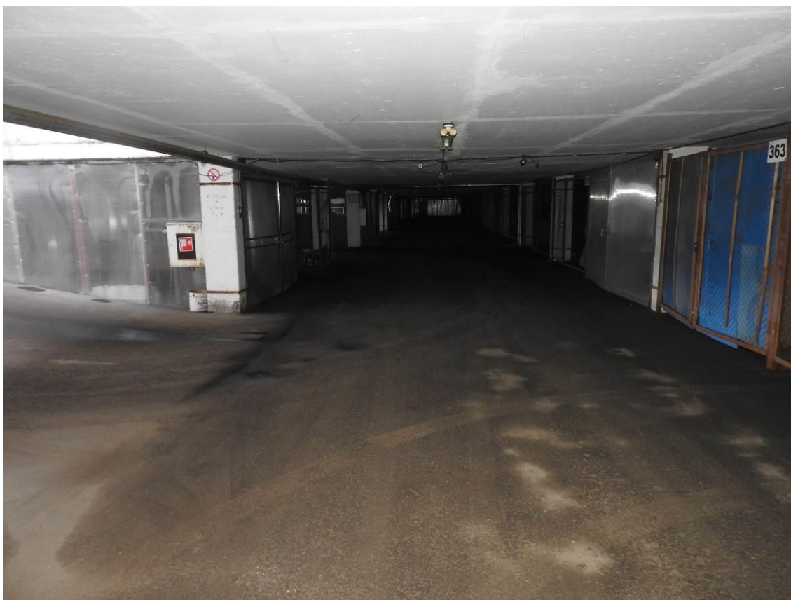
Общий вид перекрытия.
