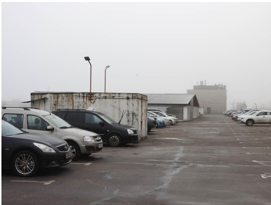
Общий вид конструкций покрытия.
