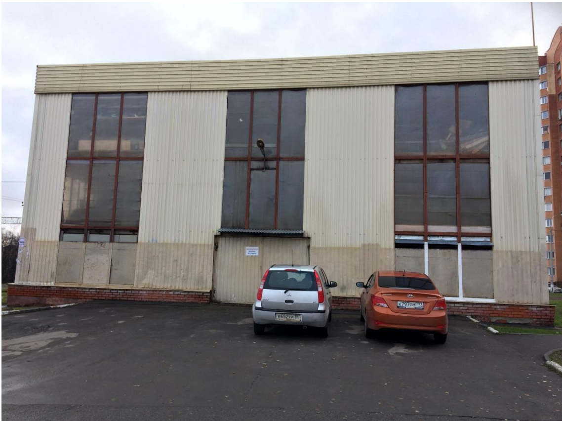
Фасад обследуемого здания по оси «28».
