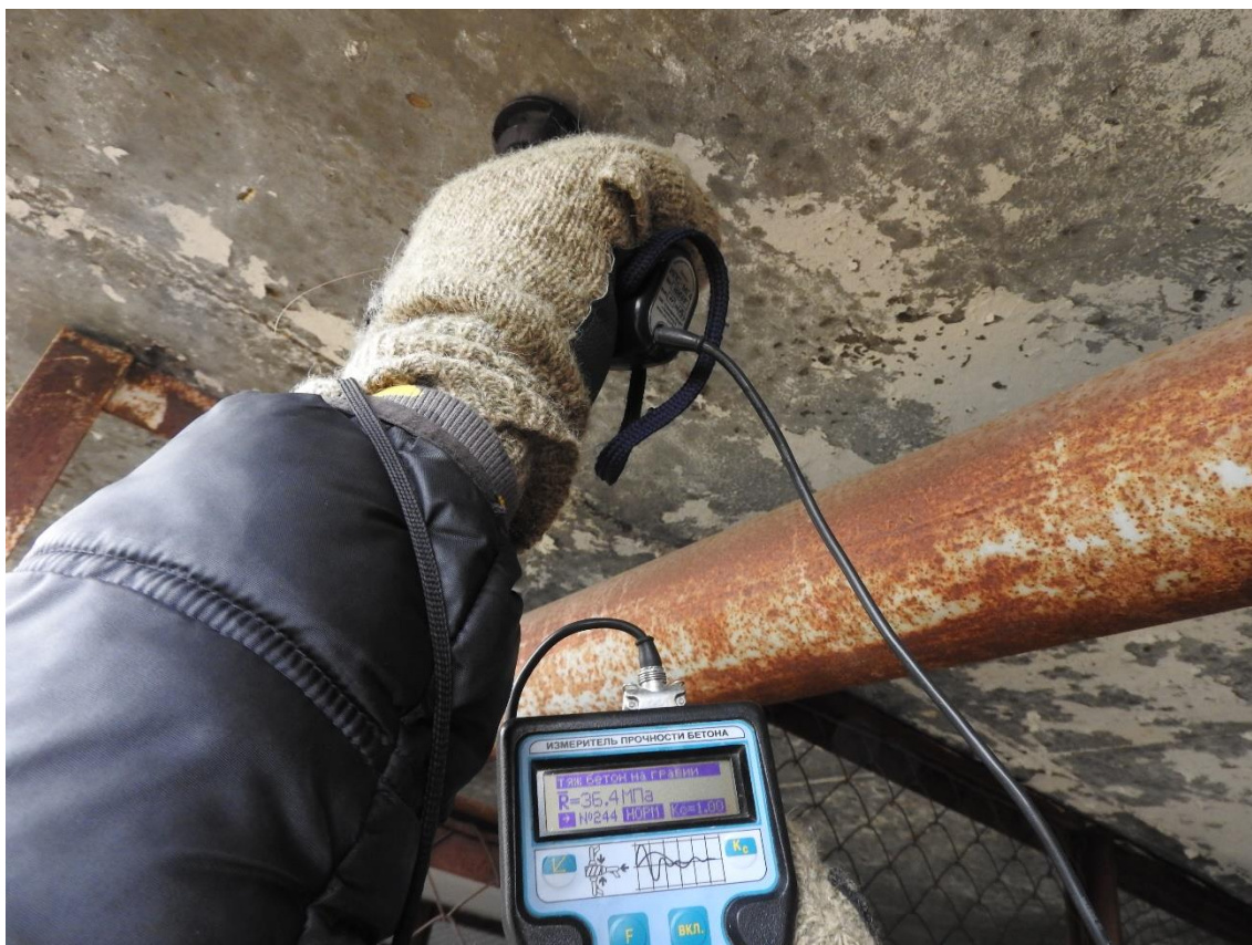
Испытание железобетонных плиты перекрытия на втором этаже прибором ИПС-МГ 4.03.
