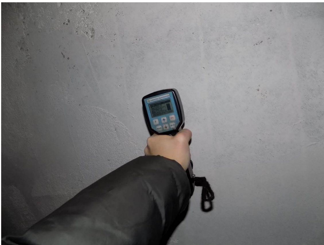
Испытание плиты перекрытия первого этажа прибором УКС-МГ4.
