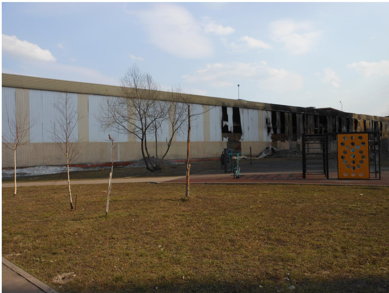
Фото 4. Общий вид заднего фасада
